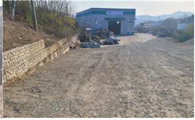
▲ 공장 부지(잡석 포설)
