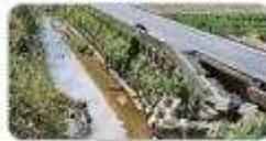
하천 제방 유실
