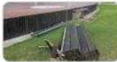
축제장 시설 파손
