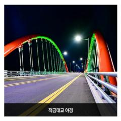
화정면 낭도와 적금도를 잇는 아치형 연도이다. 다리 연장은 470m, 폭 12.5m, 최대 경간장 120m, 왕복 2차로이며, 주변 경관과 다도해 섬들과의 조화성을 고려하여 아름다운 "중로 아치교"로 만들어졌다. 아치교란 아치형 구조물에 다리의 상판을 지지하는 다리이며, 다리 상판의 위치에 따라 상로, 중로, 하로아치교로 구분하는데 중로아치교는 교면(상판) 이 교량 상·하의 중간에 있는 교량을 말한다. 아치교는 미관이 수려하여 예로부터 많은 사랑을 받았던 교량형식으로 고대 로마 시대부터 돌로 건설되어온 오래된 양식이다.
