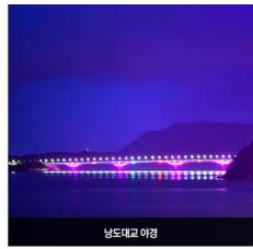
둔병도와 낭도를 연결하는 연도교이다. 국내 최장경간(170m) "PSC(prestressed Concrete) 박스거더교" 이다. 다리의 연장은 640m, 폭 12.5m, 왕복 2차로이며 점증적 경간 구성 (150m+170m+150m)으로 주항로 시인성 확보 및 리듬감 있는 경관을 연출하여 운전자 시점의 수러한 다도해 경관을 조망할 수 있도록 개방감을 확보하였다.
