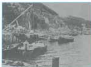
▲ 1930년 오동도 방파제 공사
