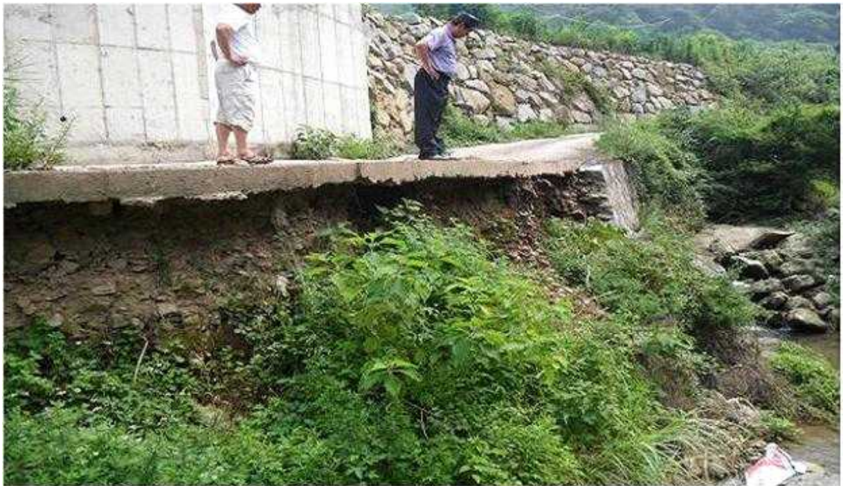
돌산읍 대율1천 옹벽 보수공사
